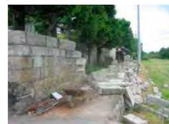
東日本大震災で倒壊したブロック塀（宮城県）
