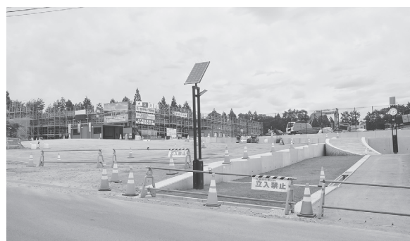
工事は順調です
