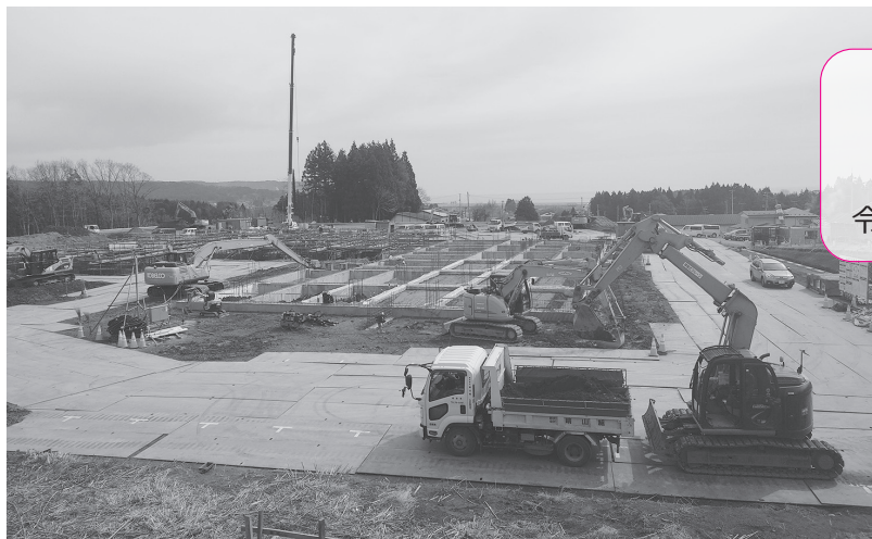
小学校建設工事が進んでいます
