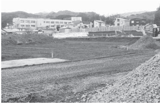
完成が期待される野田小学校建設現場
