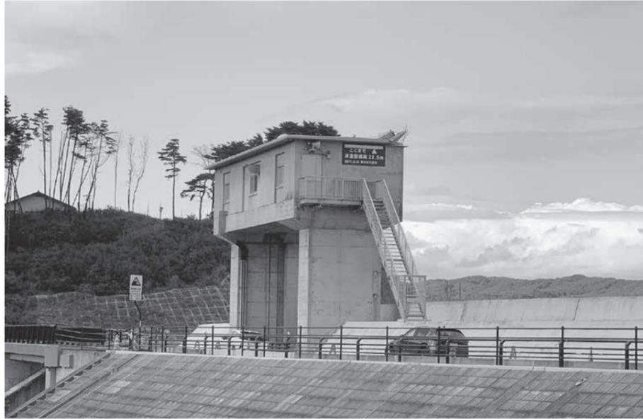
海岸保全施設として整備された米田水門は東日本大震災により被災。大津波は水門最上部まで到達しました。破損した状態での屋根部の保存と津波到達高「22.5m」の表示により、津波の記録と脅威を後世に伝える役割を果たします。
