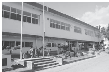
過疎対策債により小学校の改築などの事業が行われる予定です
