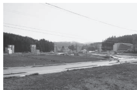
建設が進む野田 | C
