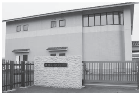
港地区にある浄化センター
