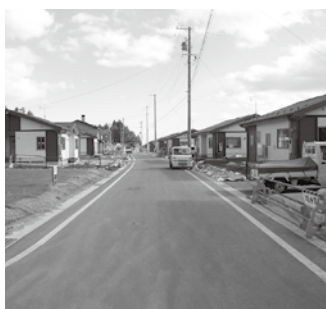
完成目前の新町地区災害公営住宅
