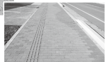
変更後の舗装路面（区画道路1号線 本町通り）
