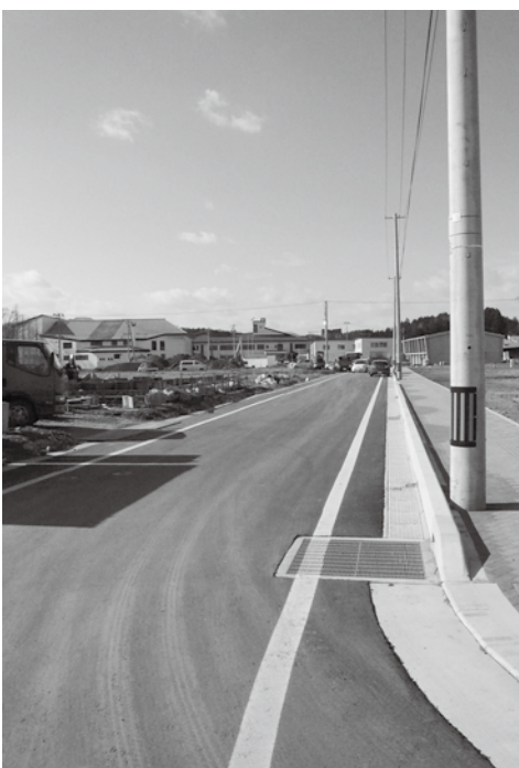
整備が進む土地区画整理区域
