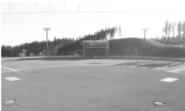
改修工事中の総合運動公園野球場
