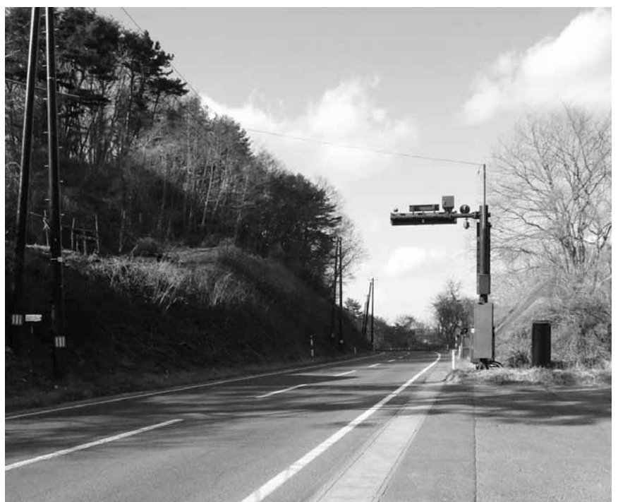
国道45号線（玉川～下安家間）大型車両が往来し、危険な状態です。
