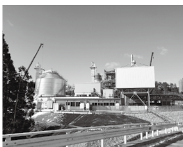
建設中のバイオマス発電所
