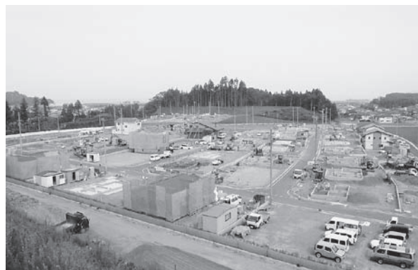
建設現場の様子
