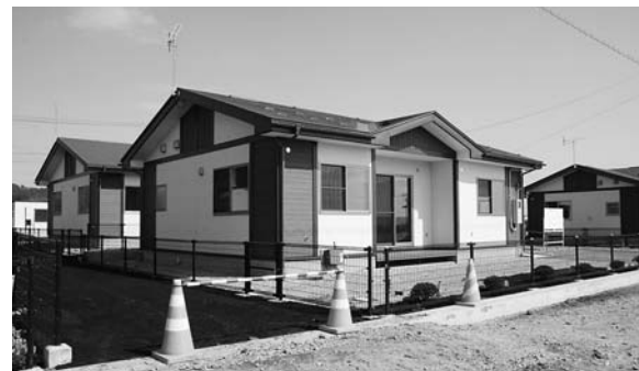
完成した本町・旭町災害公営住宅
