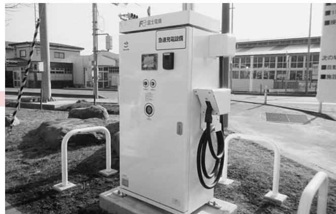
道の駅のEV充電器
