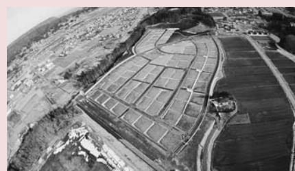
城内地区高台団地
