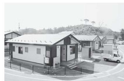
南浜団地に完成した災害公営住宅
