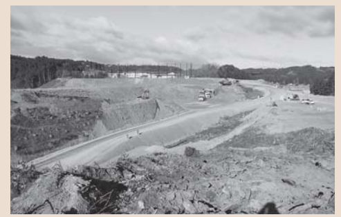
城内地区の高台団地
