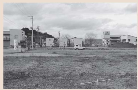
本町地区での整地工事の様子
