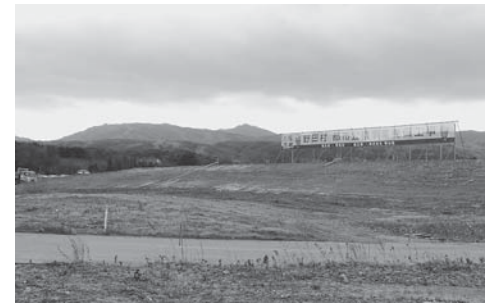
都市公園西側の高盛土
