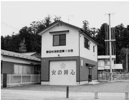
第1分団屯所災害復旧工事 1567万円
