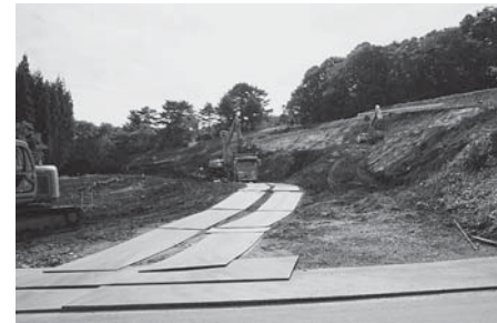
国民宿舎えぼし荘の近くに建設が進む下安家地区の高台団地
