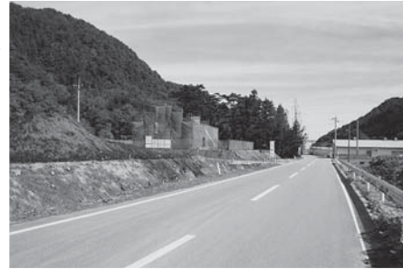
下安家で始められた宅地かさ上げ工事
