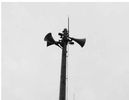
防災行政無線デジタル化工事 1億5624万円
