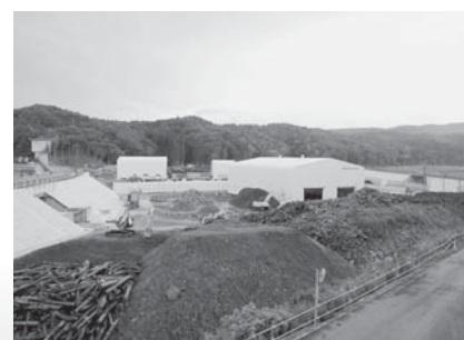
6月28日 災害ごみ中間処理施設が完成。平成25年度までの処理完了を目指します
