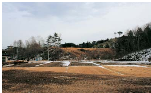
南浜地区高台団地造成地の現況
