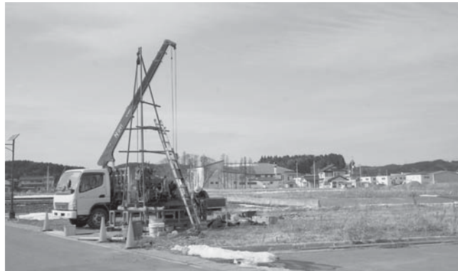
区域内では地質調査のためのボーリングが始められています
