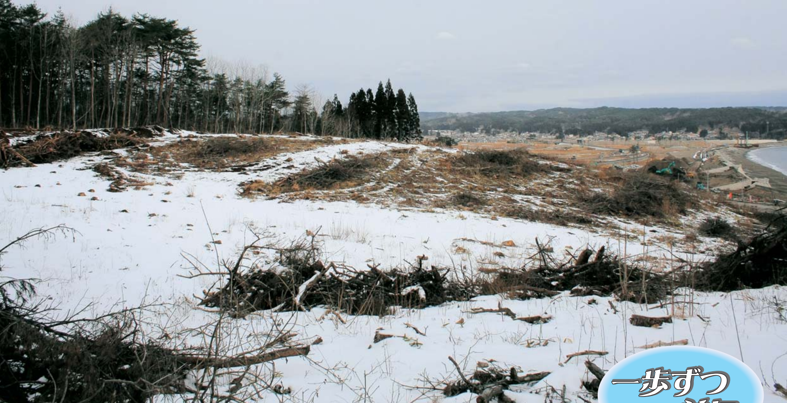
米田地区高台団地造成地。ここに新しい住宅地が創られようとしています
