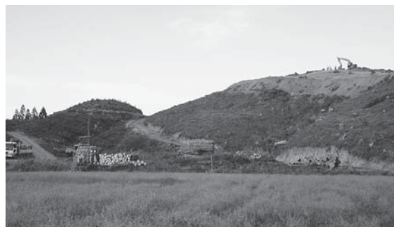
伐採が進む城内地区高台団地予定地
