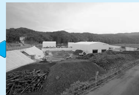
中間処理施設の全景。破碎機から破片が飛ばないように専用の施設が設置されています
