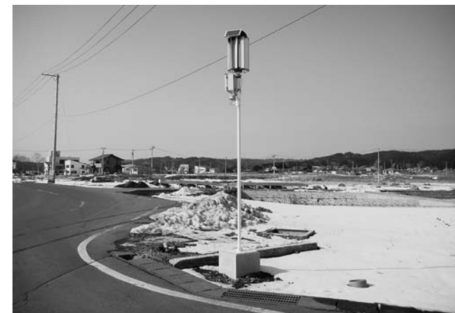
風力と太陽光のハイブリッド発電で夜を明るく照らします(旭町)
