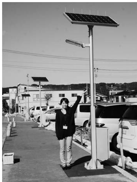
災害時の避難誘導灯としても利用できるソーラー街灯(役場前)
