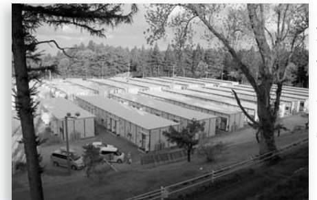
5月に完成した中学校 仮設住宅（120戸）
