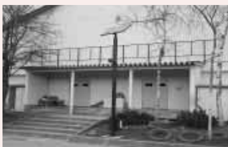
野田小体育館前に設置したソーラー街灯
