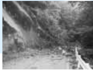
7/24 地震被災（震度6弱） 県道安家玉川線が土砂崩れ
