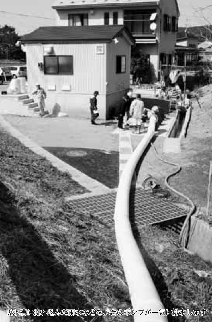
吸水槽に流れ込んだ雨水などを、3台のポンプが一気に排水します
