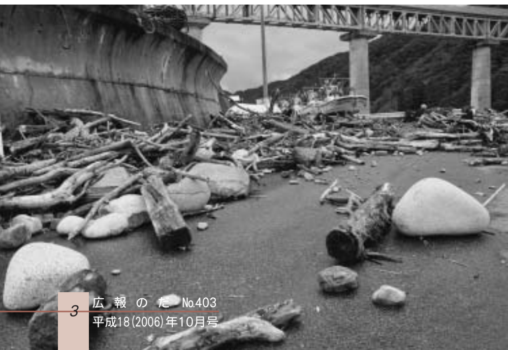
【写真上】高波によって損壊した十府ヶ浦の防潮堤【下】高波により打ち寄せられた流木。頭よりも大きな石も打ち上げられた(下安家漁港)
