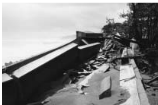
【写真上】高波によって損壊した十府ヶ浦の防潮堤【下】高波により打ち寄せられた流木。頭よりも大きな石も打ち上げられた(下安家漁港)
