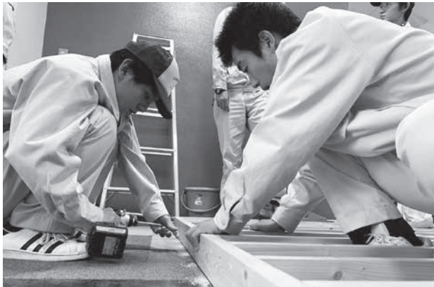
慎重かつ丁寧に材料を組み上げていきます。
