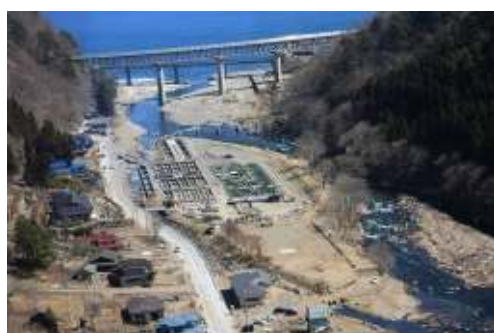
写真3－下安家地区被災状況
