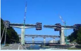
P1張出し施工の移動作業車は後退し、解体準備中です。8月に安家川上空で中央閉合(連結)します。(野田村 下安家地区)
