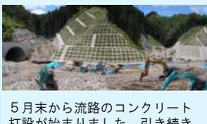
5月末から流路のコンクリート打設が始まりました。引き続き掘削、土砂運搬、法面保護、流路工の作業を行います。(野田村安家)
