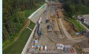
本線の切土工・排水工を行い、掘削土砂を洋野町と普代村に運搬しています。(野田村～久慈市)
