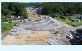
掘削、土砂運搬、路体盛土、排水工、現場打函渠の地盤改良を施工中です。(野田村・土内)
