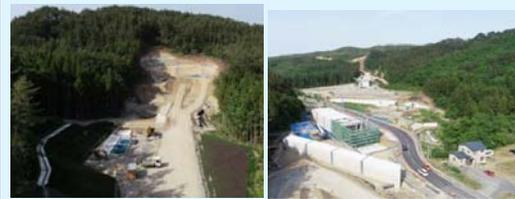
現在、国道45号函渠工・土工事・トンネルの仮設備工を行っています。トンネル掘削は、8月より本格的に掘削を行う予定です。(久慈市長内町)
