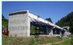
鋼桁の架設が完了しました。吊り足場の組立を行っています。(普代村 力持)
