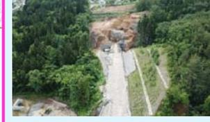
宇部ICの盛土、本線を掘削し土砂を洋野町へ運搬しています。(久慈市宇部町)
