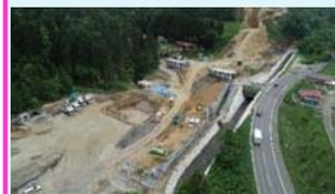
現在、本線土工事並びに、補強土壁工施工中です。(久慈市宇部町)
