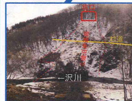
〈沢向トンネル終点側坑口〉 坑口は旧国道3号線より数十m上に出れます。
