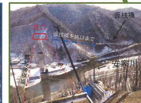
〈堀内トンネル終点側坑口〉 トンネルを施工する為の仮橋を坑口まで設置します。
