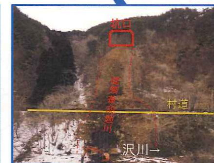
〈堀内トンネル起点側坑口〉 伐採が終わり何となく三陸沿岸道路の位置が分かります。
