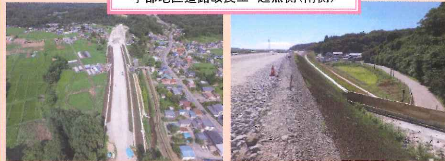
宇部地区道路改良工 起点側(南側)
