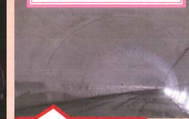
白井トンネル 覆工(ふっこう)
