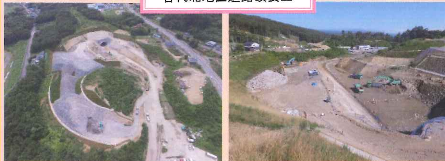
普代北地区道路改良工
