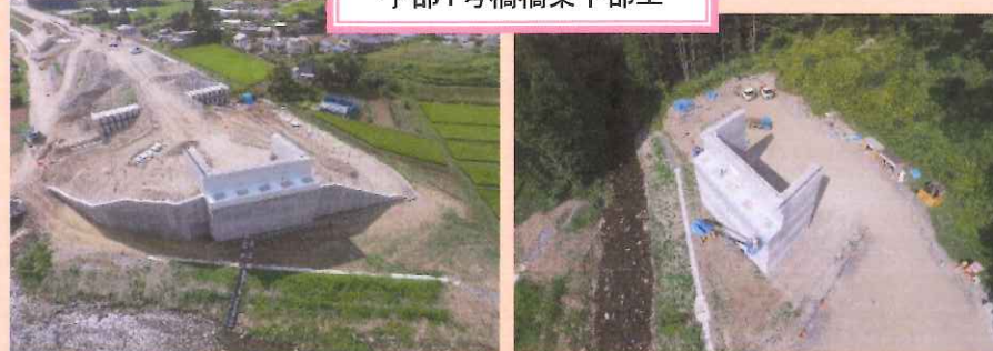
宇部1号橋橋梁下部工
