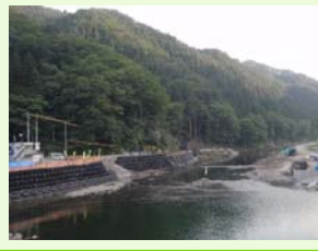
⑫【玉川地区構造物工事】 高倉建設(株)
