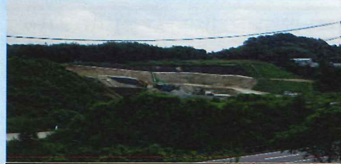
②【国道45号 白井地区道路工事】 鹿島建設(株)
