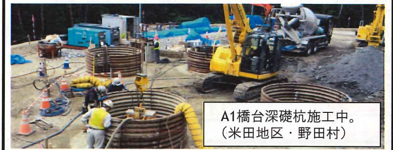
⑥【下米田地区道路改良工事】 りんかい日産建設(株)
