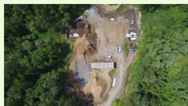
②【田子沢地区道路改良工事】昭栄建設(株)
