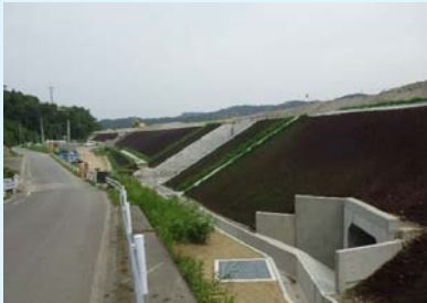
③【国道45号 白井地区道路工事】鹿島建設(株)
