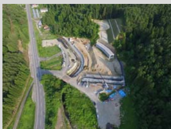
④【宇部北地区道路改良工事】(株)ノバック
