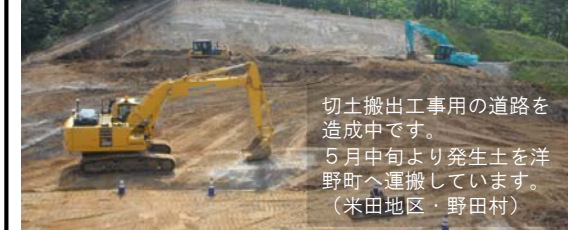
⑥【下米田地区道路改良工事】 りんかい日産建設(株)
