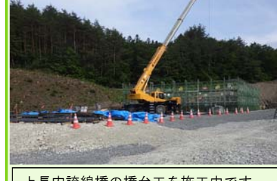
⑥【芦ヶ沢北地区道路改良工事】(株)福田組
