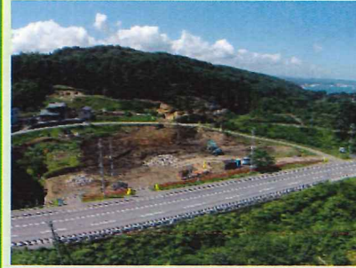
⑬【沢向地区道路改良工事】 ライト工業(株)
