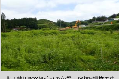
⑤【北ノ越南地区道路改良工事】(株)ノバック
