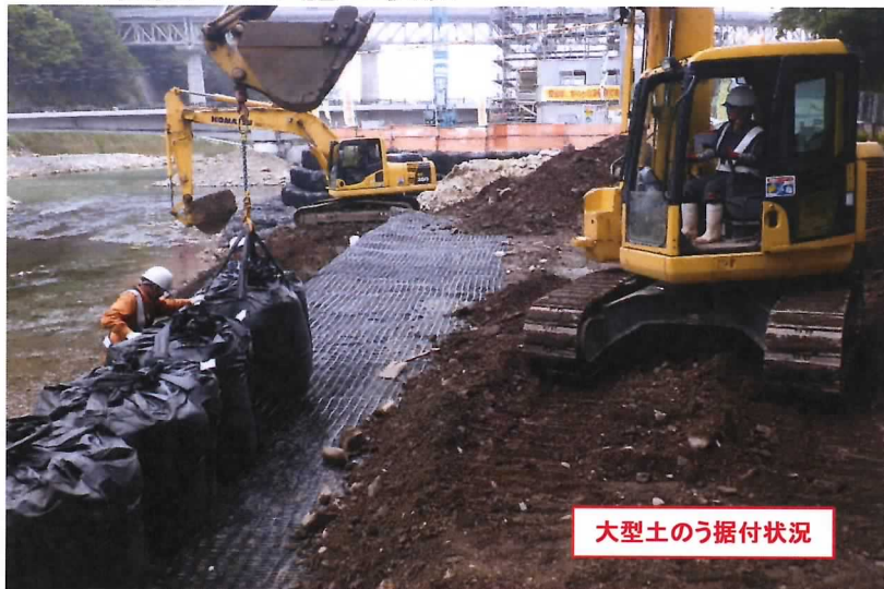
仮設ヤード施工状況
