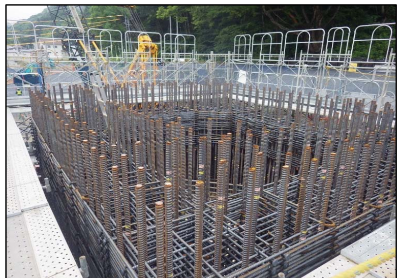
橋脚部の2LOT目、鉄筋組立を行っています。
