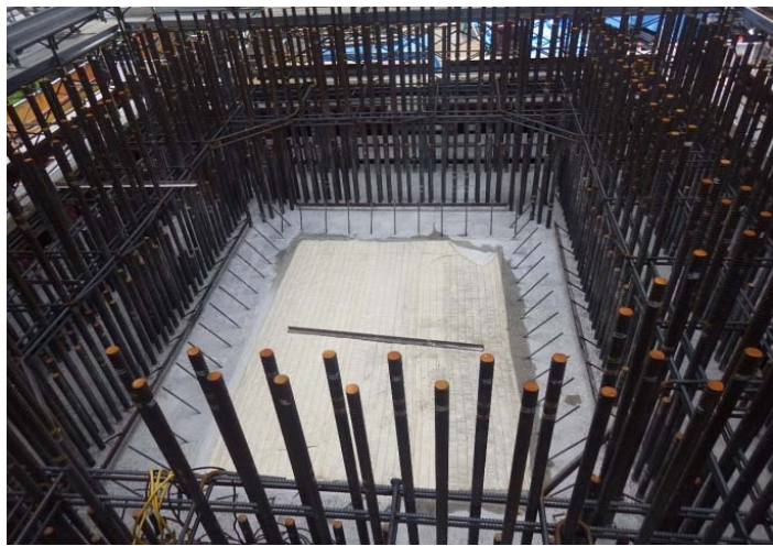
コンクリートを打設完了
