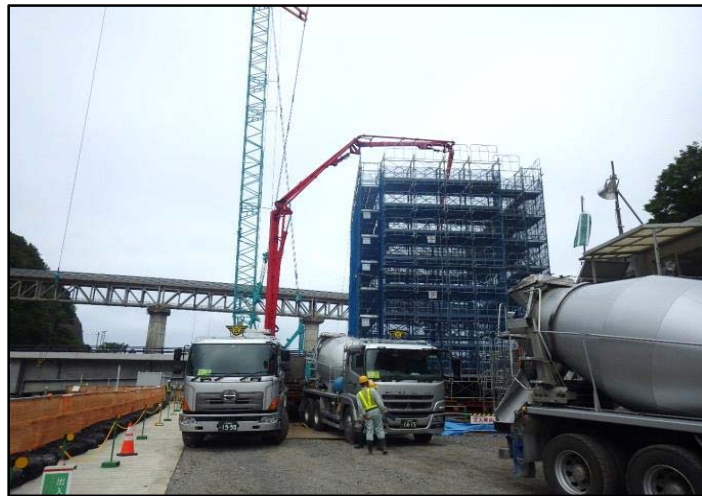
1LOT目コンクリート打設をしました。
