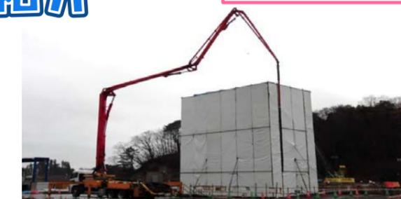
コンクリート構造物をつくる際に活躍する重機です。ミキサー車で現場まで運んだ生コンは、このポンプ車のブームを通して構造物へ流し込まれます。長いブームのおかげで高所にもコンクリートを流し込むことができます。
