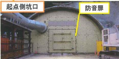
坑口(こうぐち)はトンネルの入口です。発破や重機の騒音を抑える防音扉を設置しています。
