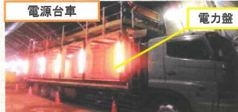
電源台車は坑内の照明や重機へ電力を送ります。トンネル工事の心臓部とも言えます。
