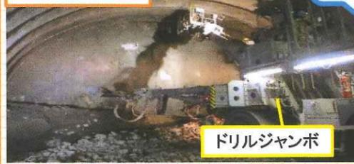
切羽は掘削の最深部です。白井地区では、ドリルジャンボで岩盤に爆薬を詰め(装薬)、爆破させて掘り進めています。
