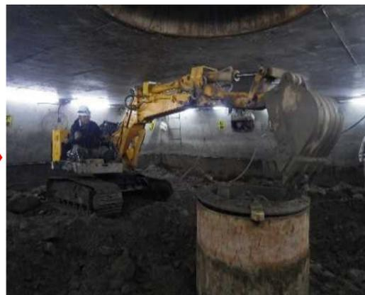
小割した石を土砂バケツに積込外に出します。
