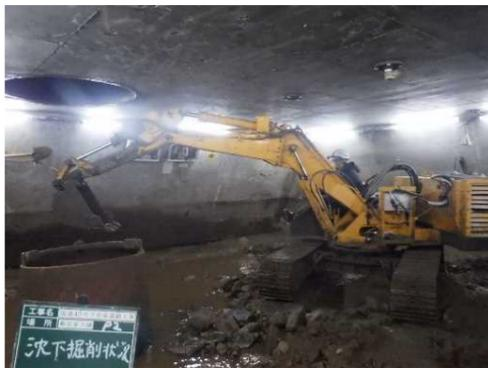
細くなった岩石を重機で土砂バケツに入れて外に出します。
