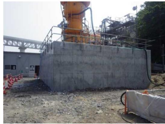
前月に比べ1.0mほど下がりました。躯体天端が地面付近に到達するまで沈下させていただきます。
