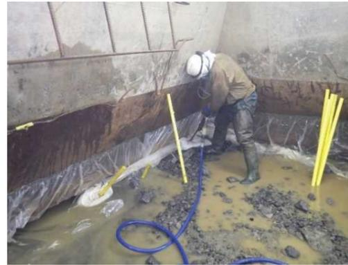
P1、P2ともに岩盤がでてきており火薬を入れる穴を削孔してます。
