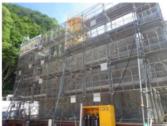
7L0T部分の躯体まで構築が終わりました。天端まで躯体沈下させます。
