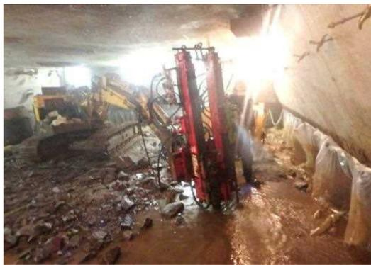
自動削孔機械を使用して削孔し発破掘削を行っています。
