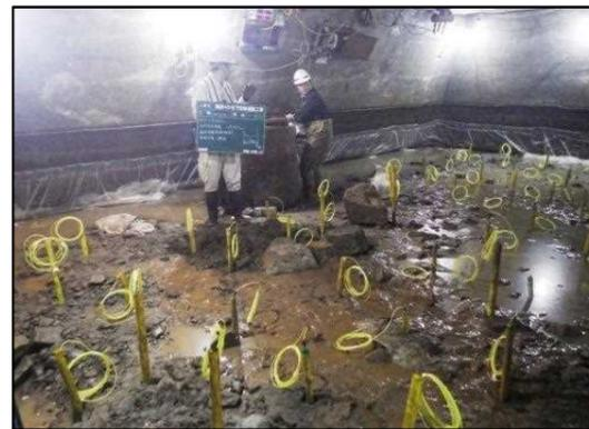
岩盤が作業室内全面に出ており発破を行いながら沈下掘削を行っています。
