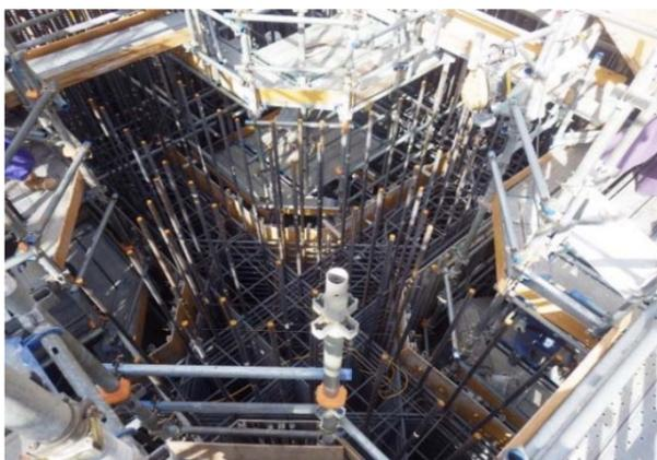
P2橋脚5LOT部の打設に向けて型枠の組立中です
