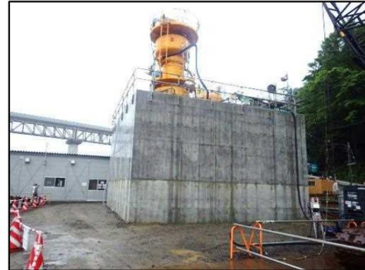
躯体の外足場を撤去し、躯体天端が地面付近に到達するまで沈下させていきます。
