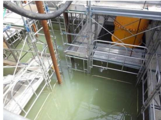
躯体を沈下させるために躯体に水を貯め荷重を加えています。
