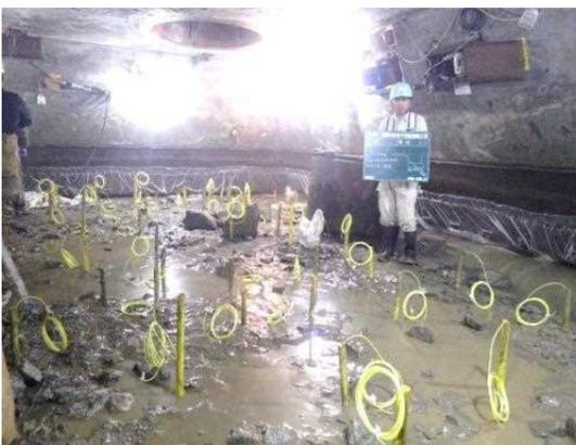
P2も岩盤が作業室前面にきているので、全面発破掘削を行っております。
