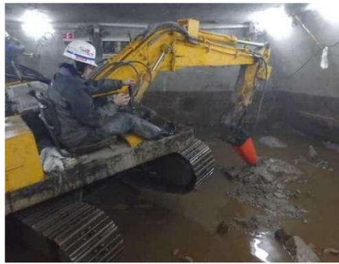
ブレイカーという機械で、亀裂の入った岩盤をさらに起こして、外にだします。
