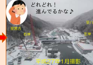
平成27年1月撮影 右岸側は橋の基礎となる場所を先行して掘削中です。左岸側は施工するためのヤードの構築が完了です！
