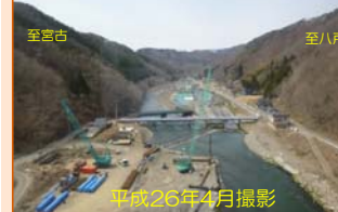
平成26年4月撮影 手前のクレーンは県道の嵩上げ工事が着手されていて、この時ケーソン工事はまだ準備中です。
