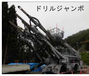
トンネル工事の主役的な機械です
