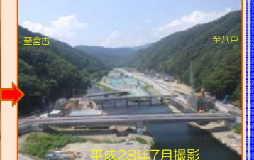
平成28年7月撮影 右岸左岸ともに橋の土台となるケーソンを構築中です！8月の台風10号によって被災しましたが、今、全力で復旧作業中です！
