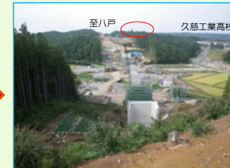
平成28年8月撮影 野田IC橋の橋台や橋脚が施工され道路が通る場所がわかります。
