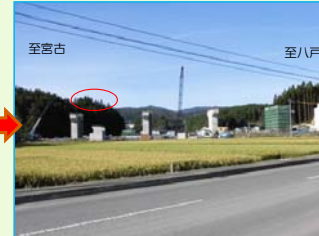
平成28年8月撮影 野田IC橋の土台となる橋台、橋脚の施工が進んでいます。
