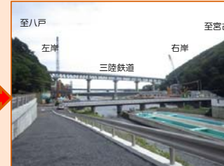
平成28年8月撮影 右岸左岸ともにケーソン工事が進んでいます。
