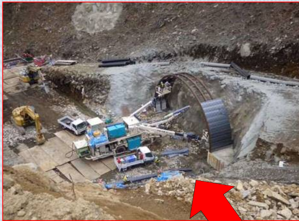
安家トンネル工事進捗状況
