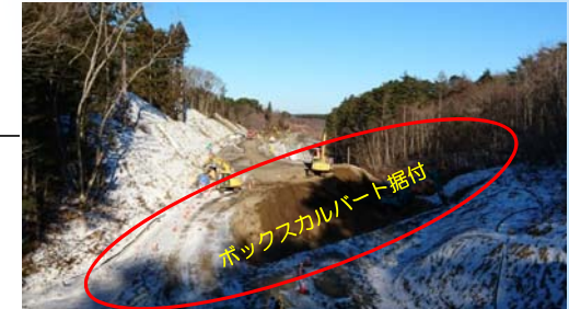
①宇部地区【国道45号 宇部トンネル工事】 大日本土木㈱
