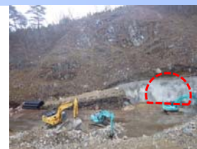
安家トンネル 延長997m
