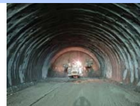
浜山トンネル 延長1582m
