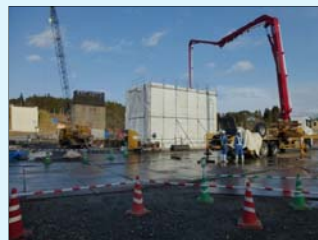
橋の上部を支える下部構造物施工の様子
