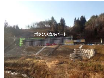
③宇部地区【久慈宇部IC道路工事】 嶺新井組
