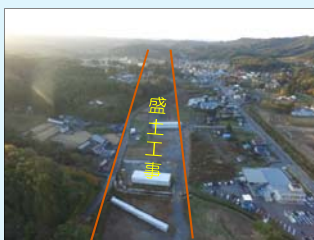
盛土工事が展開していく久慈市宇部町
