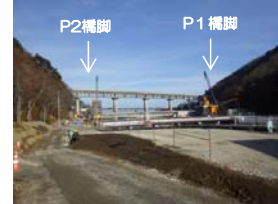
新安家大橋下部工
