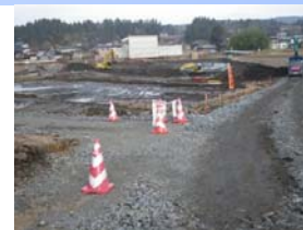
上泉沢地区盛土
