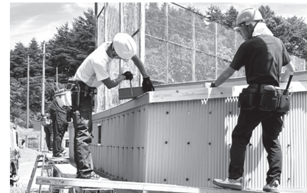
修繕を行う屋根職人
