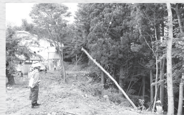
樹木伐採の様子
