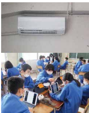
▲教室の様子 （上：教室に設置されたエアコン 下：タブレットを使った学習）
